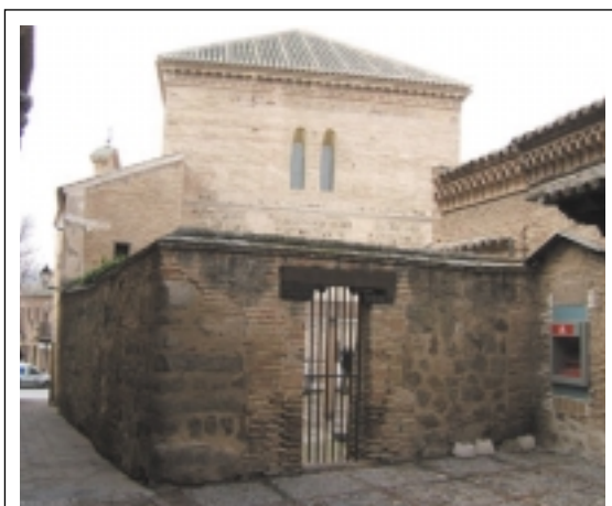
Die aus dem 14. Jh. stammende Synagoge von Samuel Ha-Levi, auch Sinagoga del Tránsito genannt, wurde hervorragend restauriert.
